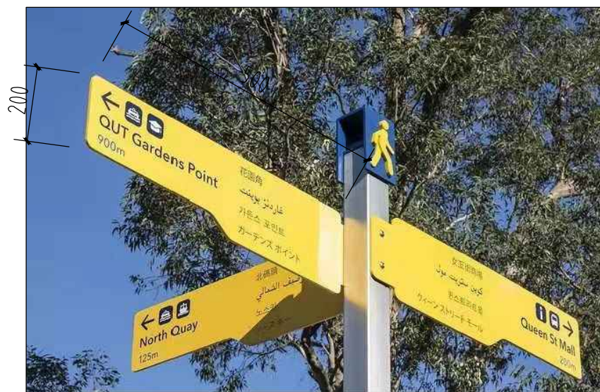
注: H=3.2\text{m} , 不锈钢管+不锈钢板
